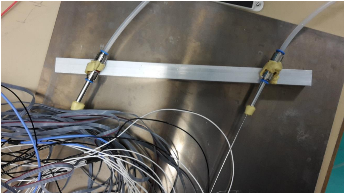
Photographie embranchement tuyaux/arrivée d'eau
